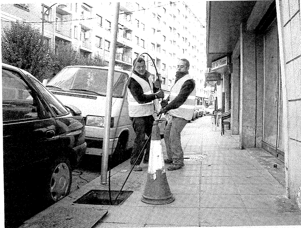
En la segunda fase, la fibra óptica se instalará por toda la villa ermua-rra. :: A. L.
