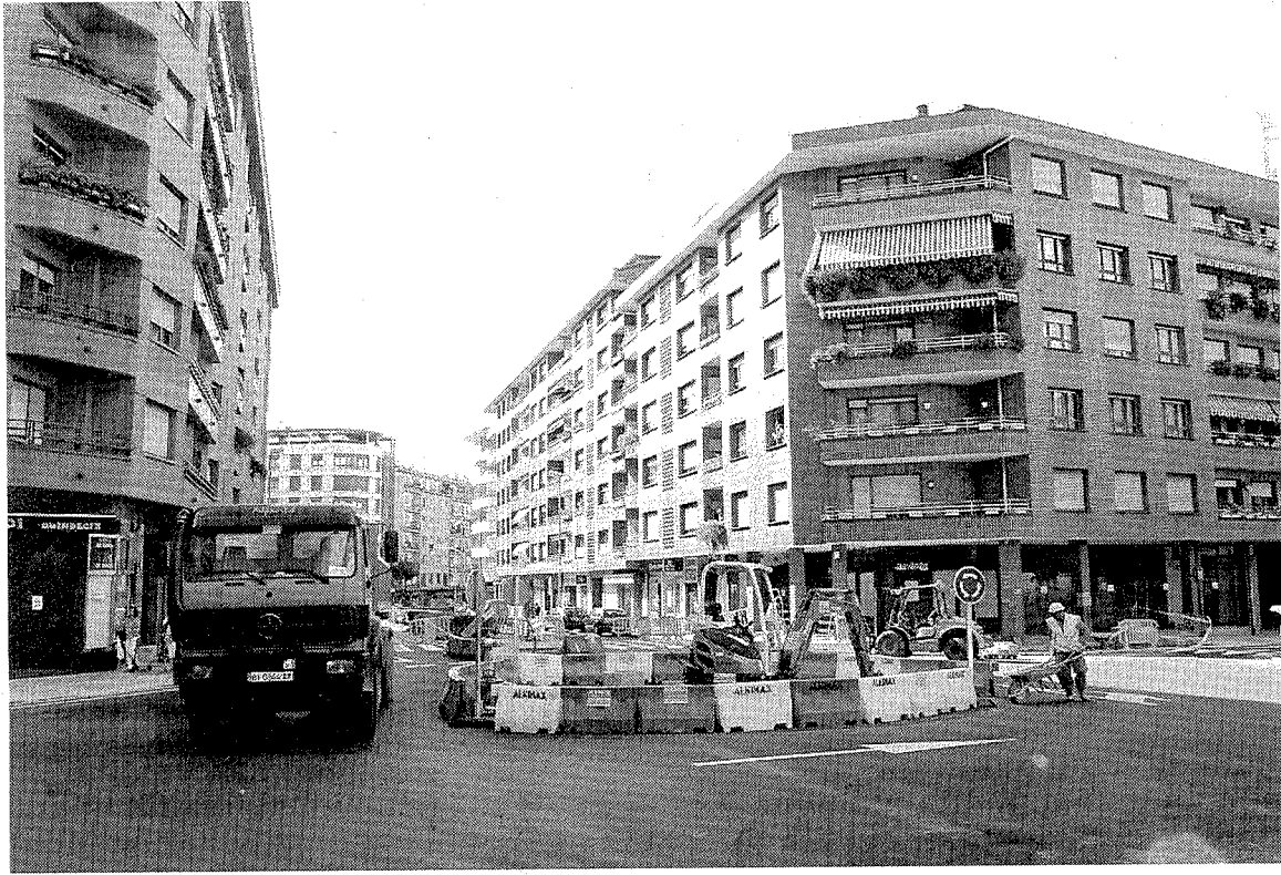
La construcción de la rotonda de Magdalena ha conllevado la eliminación de ocho semáforos. FOTO: I. GORRITI
