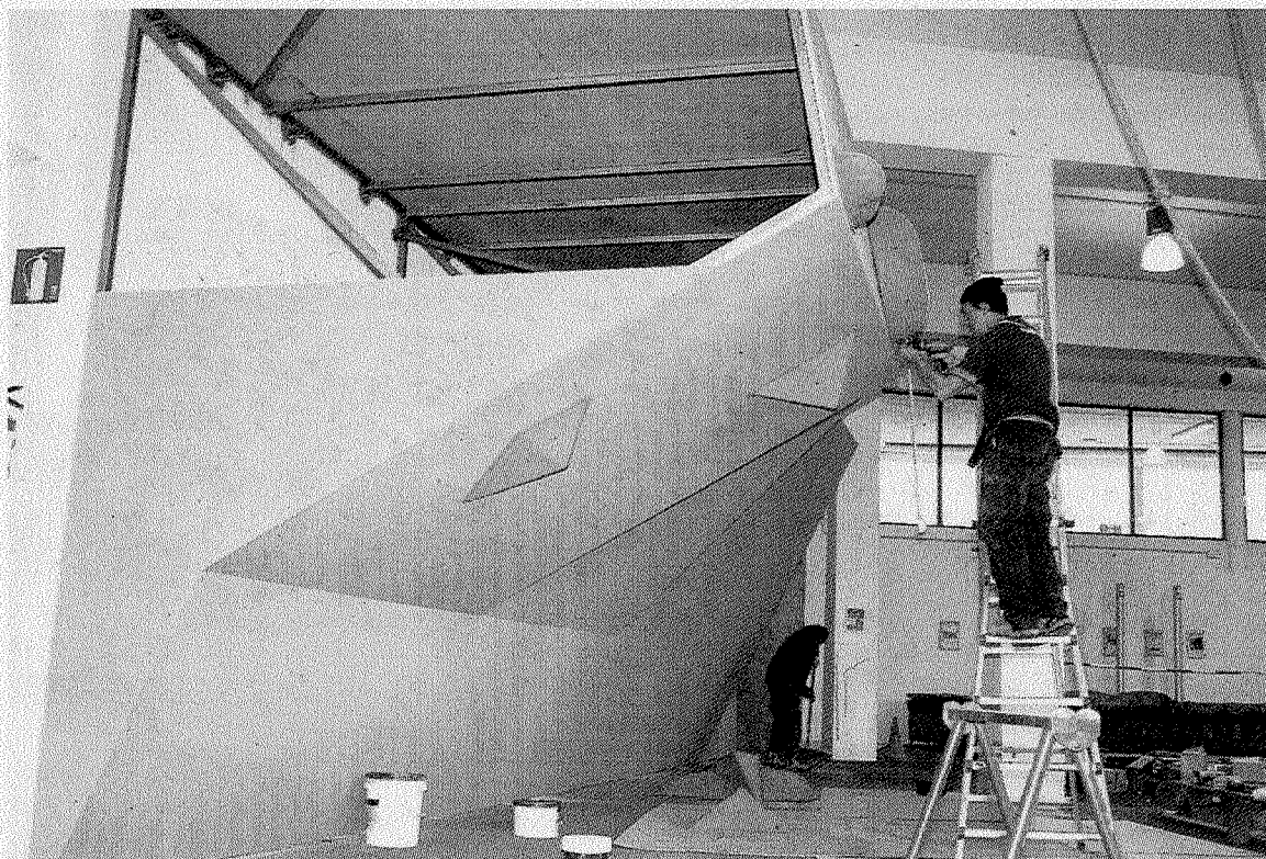
Los operarios procedían durante la jornada de ayer al montaje de la estructura del rocódromo. ** A. L.
