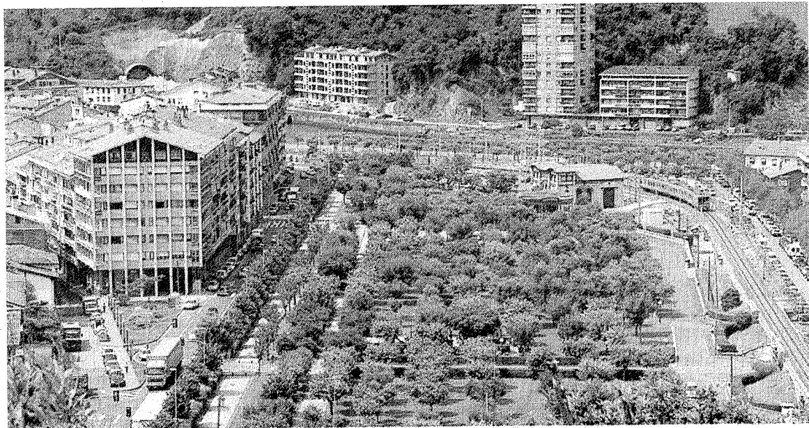
Vista parcial de Deba, con el gran parque en primer término.
