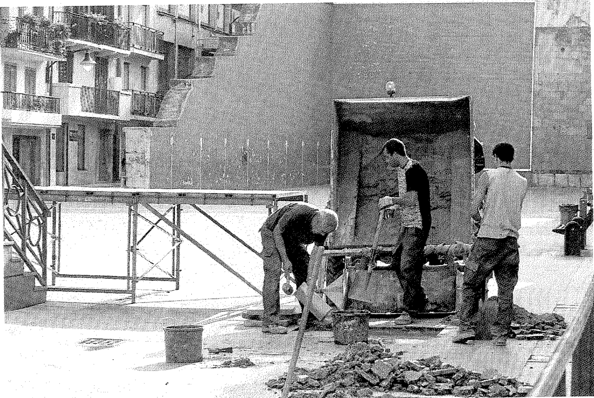
La brigada trabajando en el arreglo de la plaza Cardenal Orbe de la villa ermuarra. A. L.
