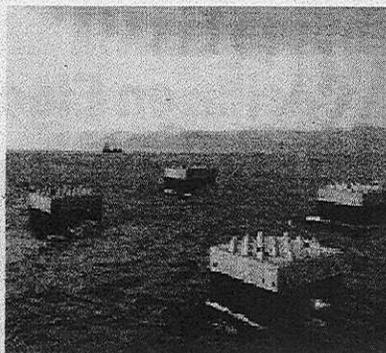
Las 16 unidades de la planta energética para el Muelle de Abrigo, unidades que tendrán un conducto superior como las recogidas en las instaladas en la planta escocesa. (GORRITIBEREA)
