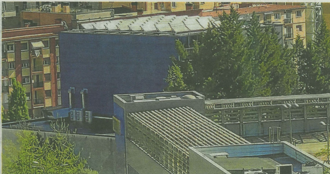
El tejado del polideportivo tiene instaladas placas fotovoltaicas que colaboran en su suministro energético. A.L.
