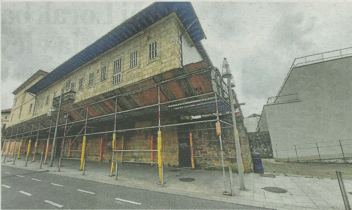
Licitación para impermeabilizar la cubierta de la antigua residencia Urribarri. Foto: Ayuntamiento Durango
