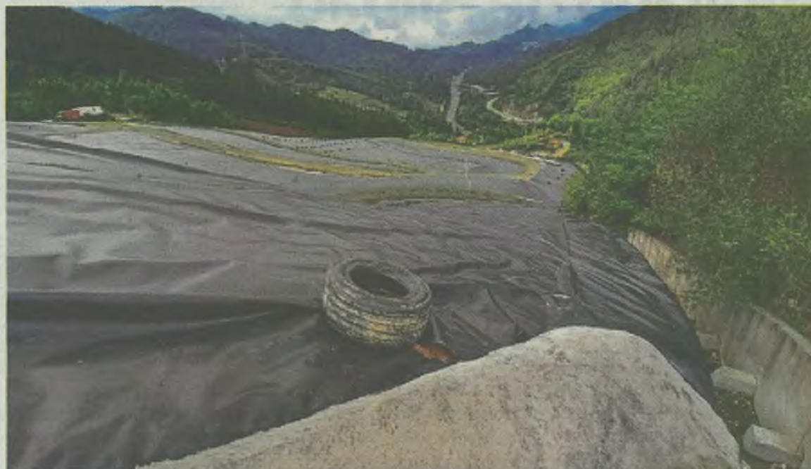
Estado de la lámina temporal que cubre el vertedero en una imagen recogida por los inspectores. GOBIERNO VASCO
