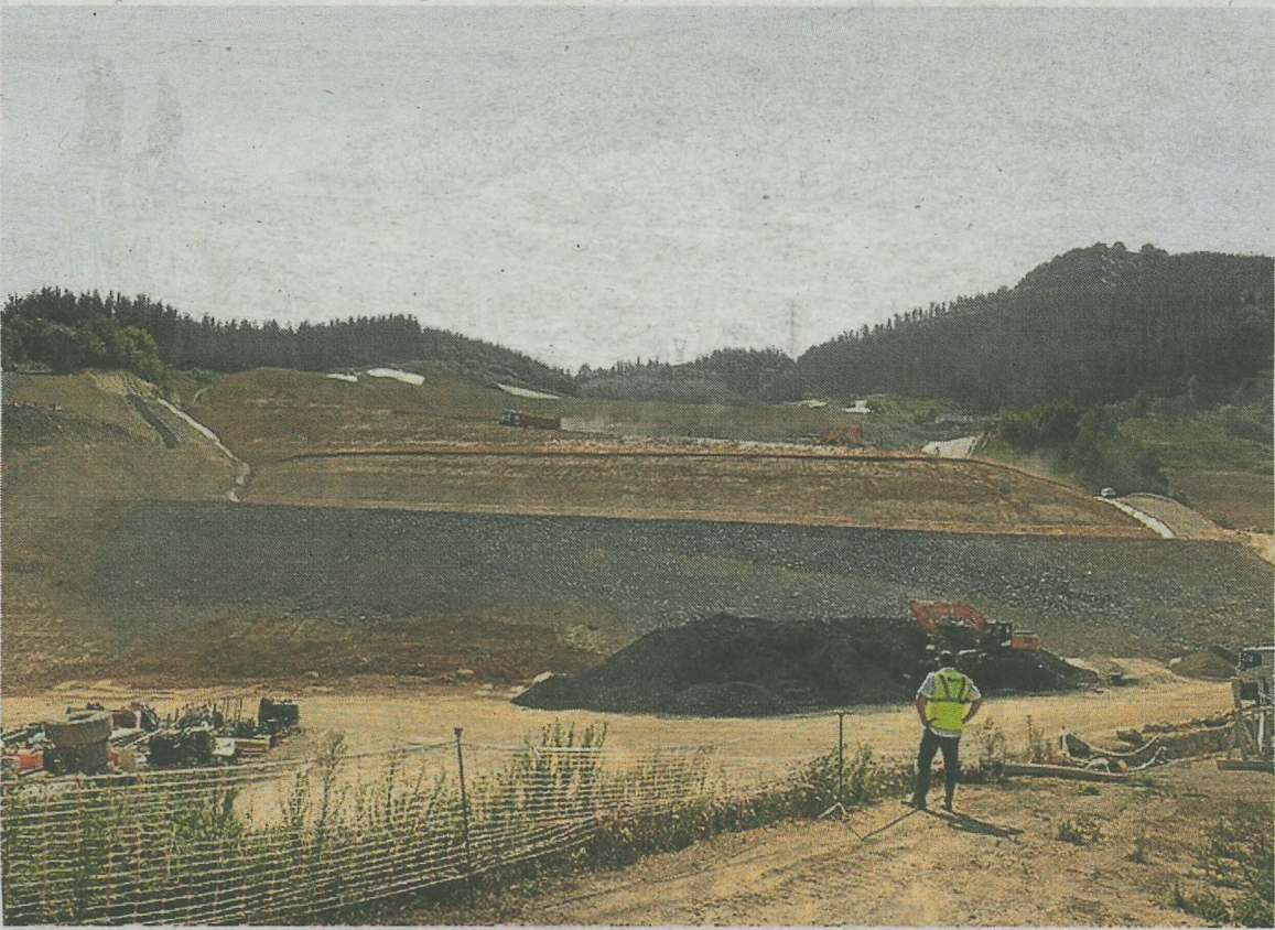
Obras de estabilización del terreno (2022) que se vio afectado por el derrumbe del vertedero. IREKIA
