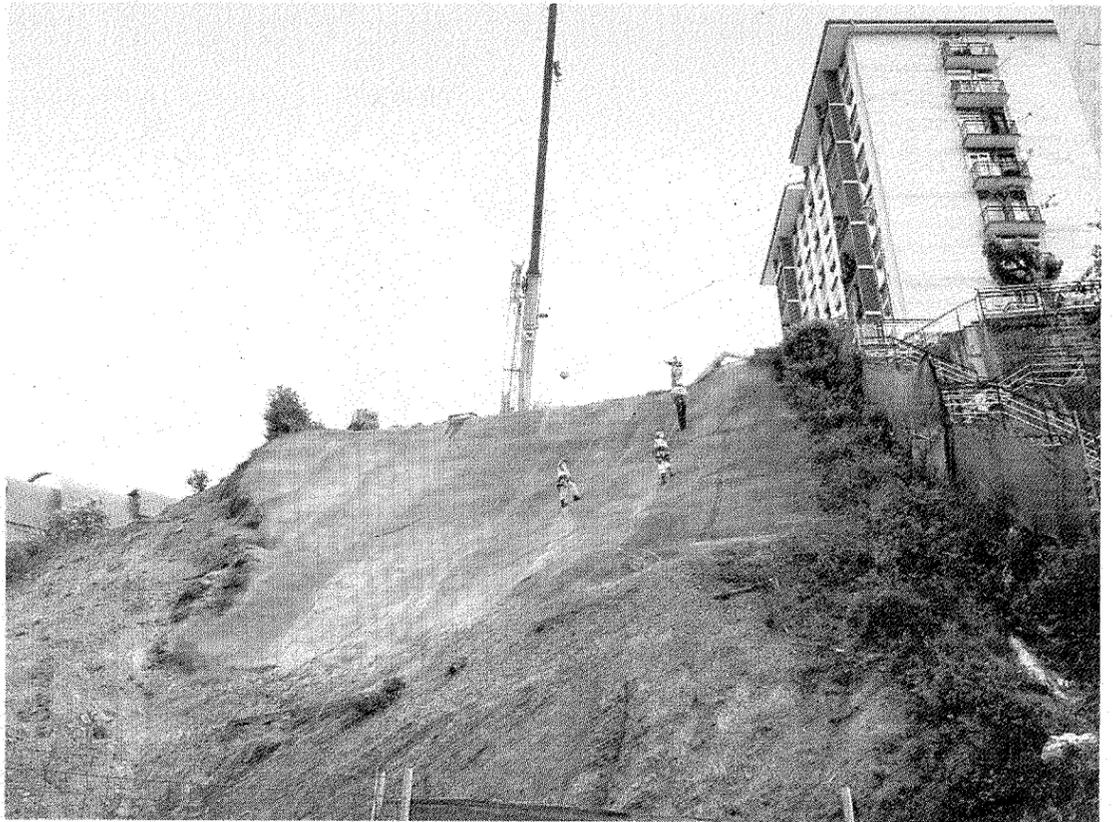
Operarios trabajando en las labores de cementación del talud para evitar más desprendimientos. :: A. L.
