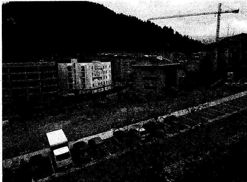
CONSTRUCCIÓN. Zona en la que se van a edificar los apartamentos en alquiler de Abeletxe. / M.E.
