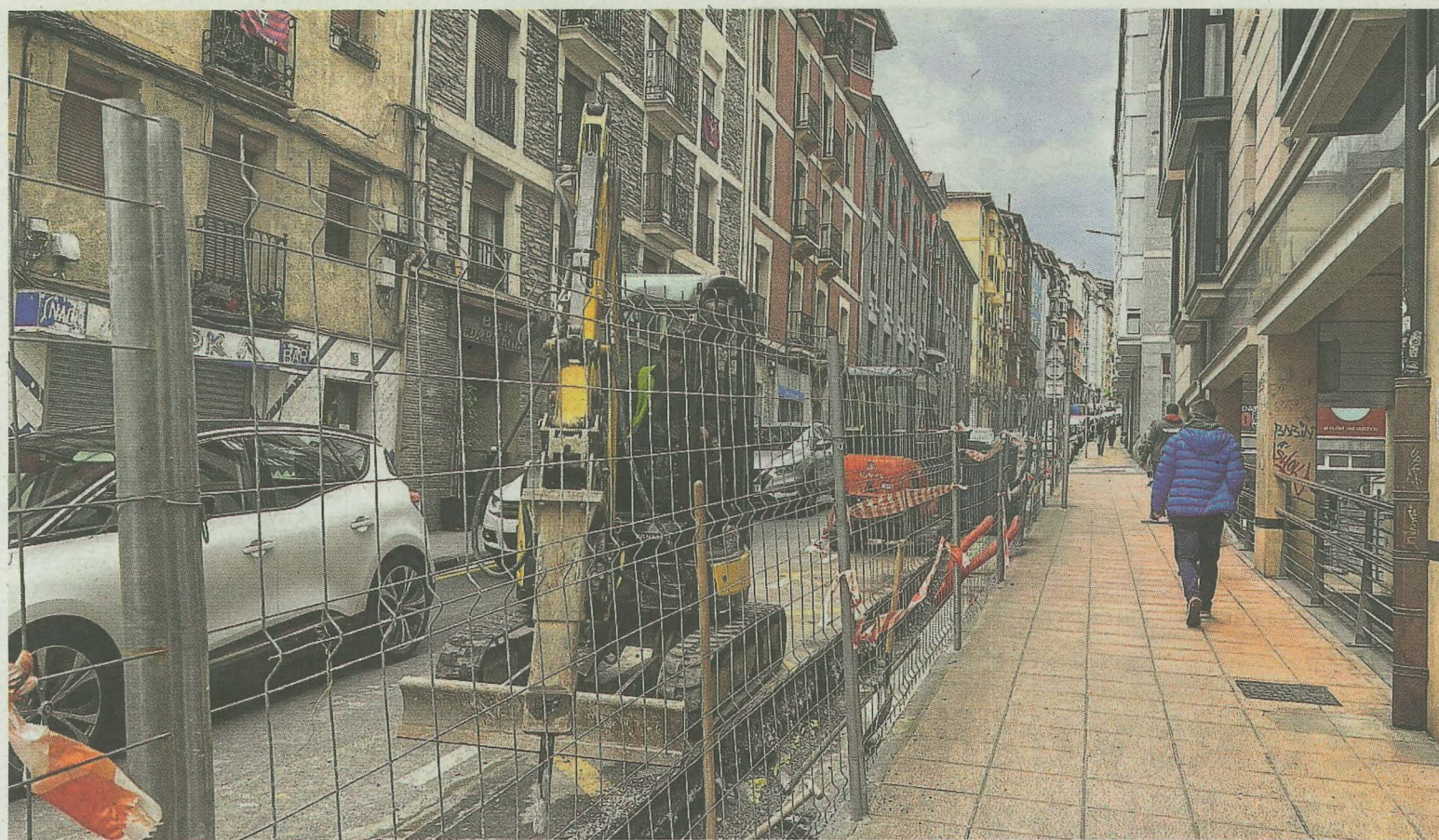
Las obras de instalación de fibra óptica a Andretxea ha generado que se vuelva a levantar la calzada de la calle Isasi. ECHALUCE
