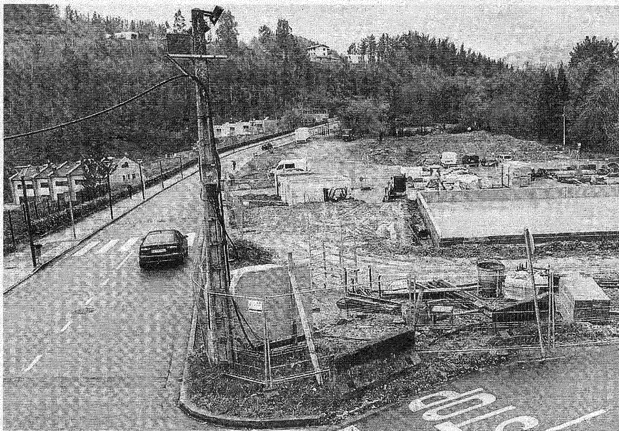
Las piscinas al aire libre de Betiondo se abrirán previsiblemente este verano. Foto: Ayuntamiento de Ermua
