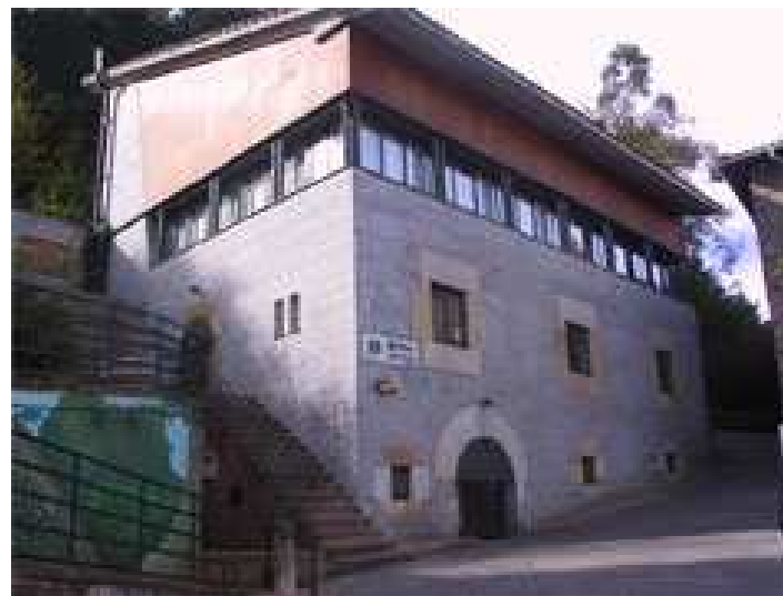
Área Desarrollo local. Casa Torreta. Actualidad
