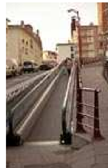
Escaleras mecánicas Ongarai.
