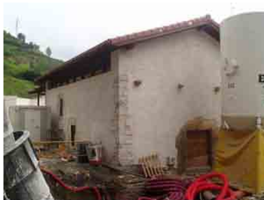
Rehabilitación Ermita San Antonio en la actualidad
