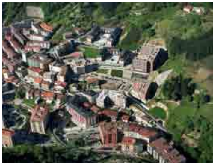
505 plazas de aparcamiento Abeletxe.
