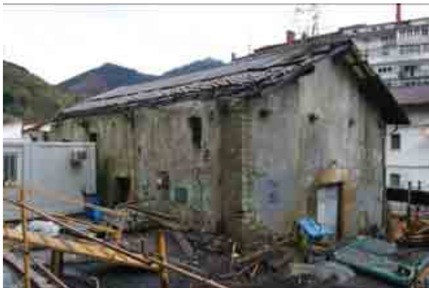
Traslado, descontaminación, Antiguo Taller en Ermita San Antonio.
