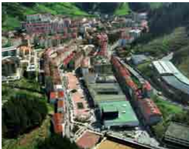
Aparcamientos San Pelayo.
