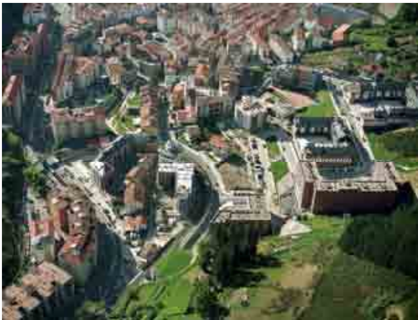
104 plazas de aparcamiento Abeletxe.
