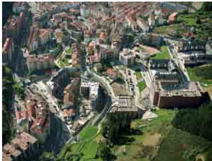
104 plazas de aparcamiento Abeletxe.
