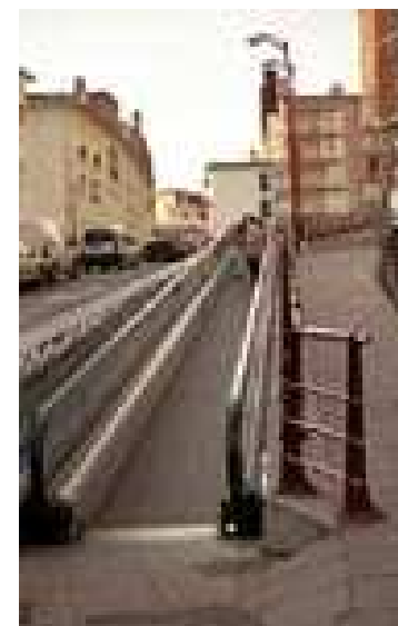
Escaleras mecánicas Ongarai.
