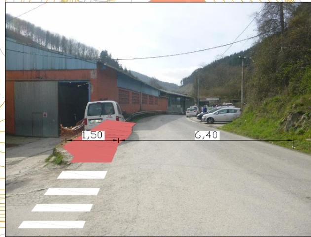
Retirada de bionda para acondicionamiento de vial peatonal y posterior colocación. A su vez tramo ampliación de carretera.
