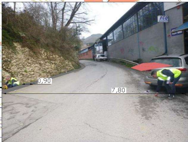
Retirada de bionda para acondicionamiento de vial peatonal y posterior colocación. A su vez tramo ampliación de carretera.
