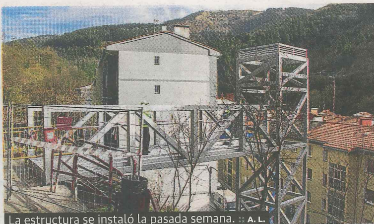
La estructura se instaló la pasada semana. ■ A. L.
