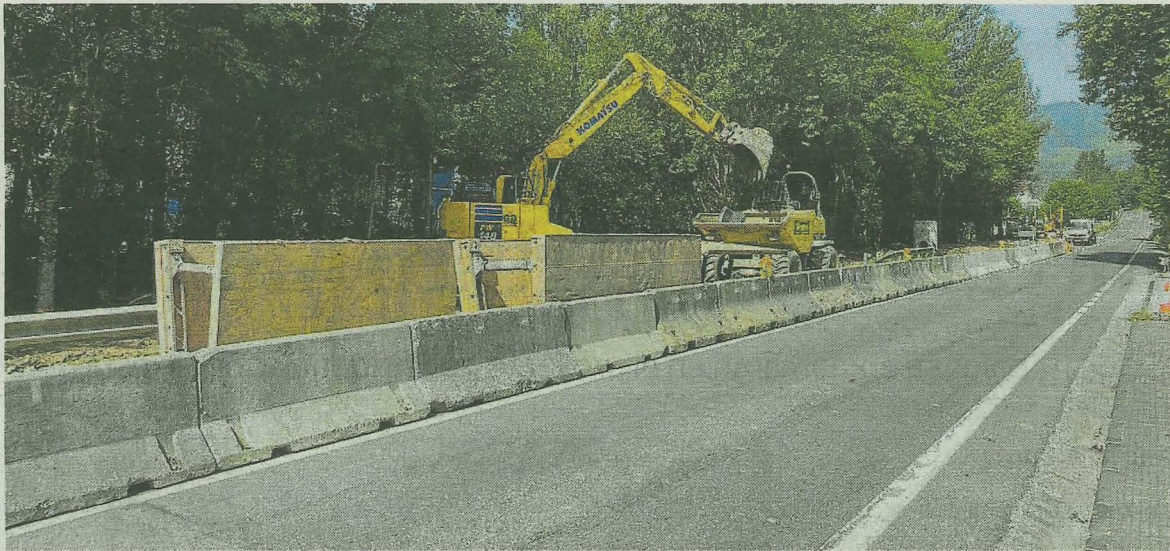
Estas obras supondrán mejorar la calidad de vida de los habitantes de Mallabia. Foto: DEIA
