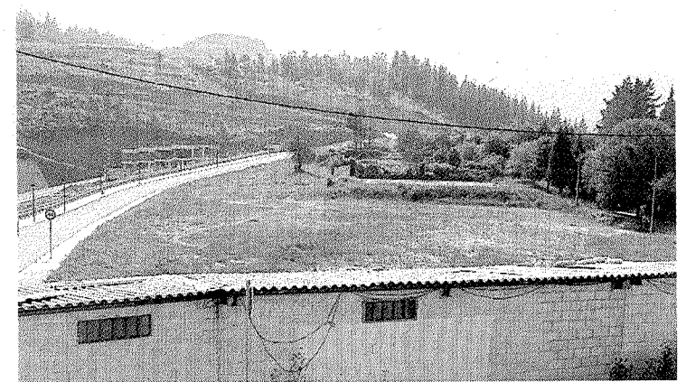
Uno de los túneles pasará bajo la explanada de Betiondo. :: A. L.
