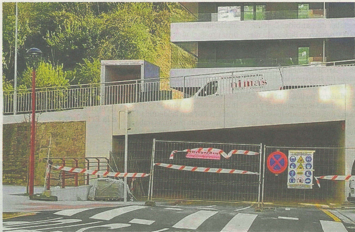
En la imagen se puede apreciar la caja que albergará el nuevo ascensor del parking de Lomipower. A.L.
