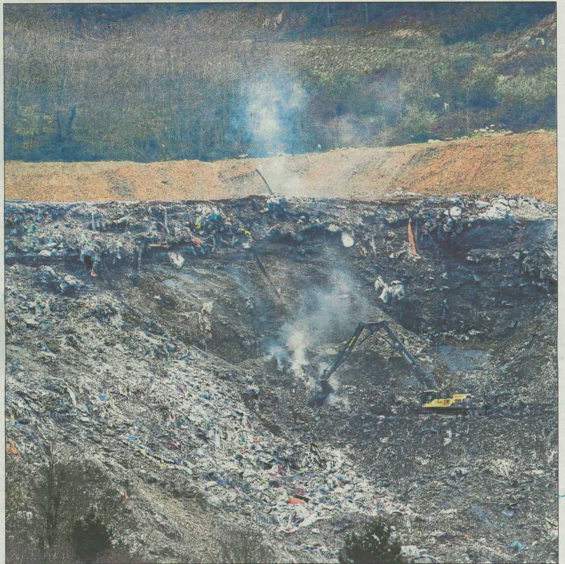
La zona derrumbada, todavía humeante dos semanas después del desastre.
