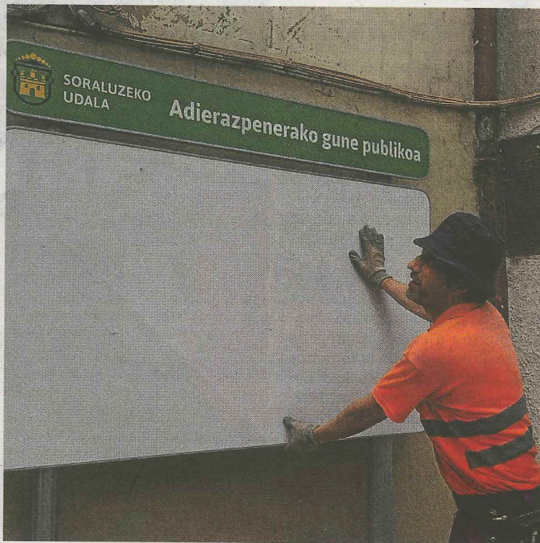
Un operario coloca uno de estos paneles. :: ISASTI
