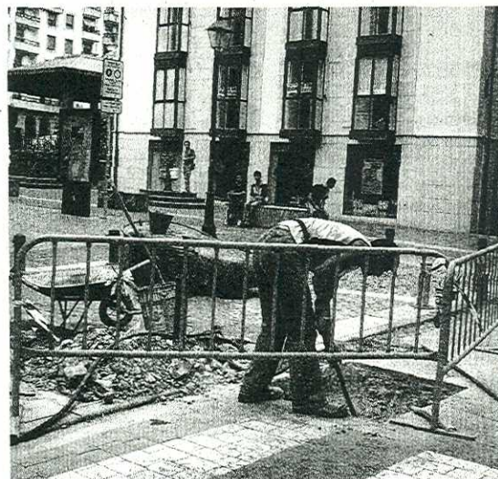
DE NUEVO. Más trabajos en la calle Probaleku. / A.L.
