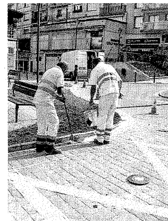
Trabajos de pintado. :: A. L.
