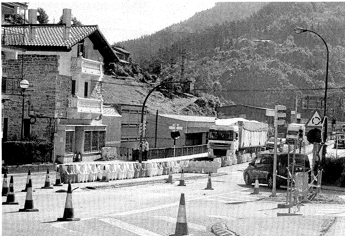
Estado en el que se encuentra la N-634 en el barrio de San Lorenzo debido a las obras. ■ A. LASUEN
