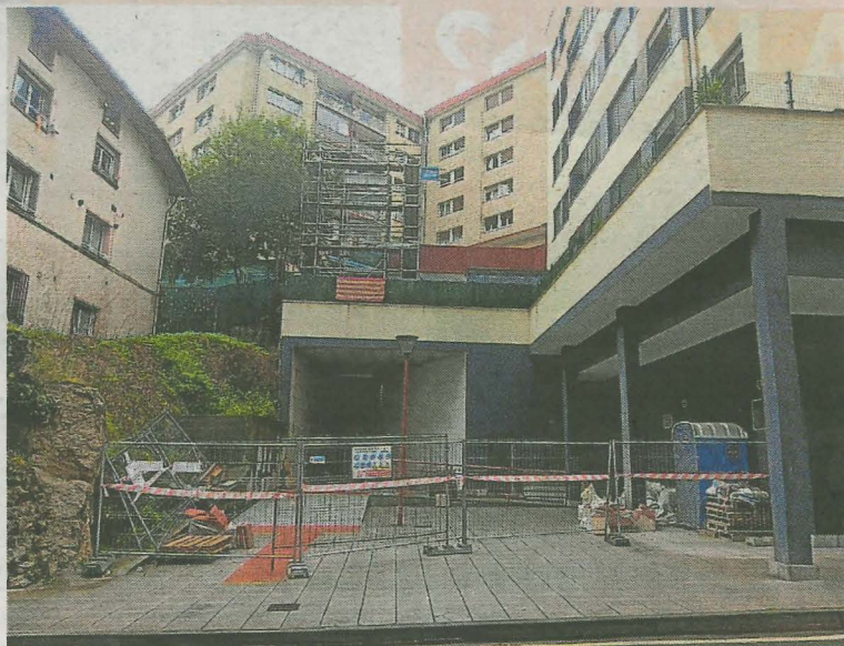
Se prevé que el ascensor de Zeruko se concluya el próximo mes. A. L.
