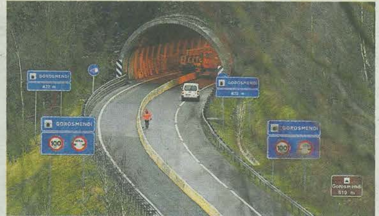
Operarios preparan el bypass que funcionará desde esta noche. LOBO
