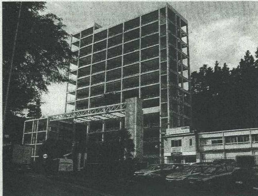
Finalizada ya toda la estructura del edificio, ahora se acometerá la fachada ventilada. / A. L.
