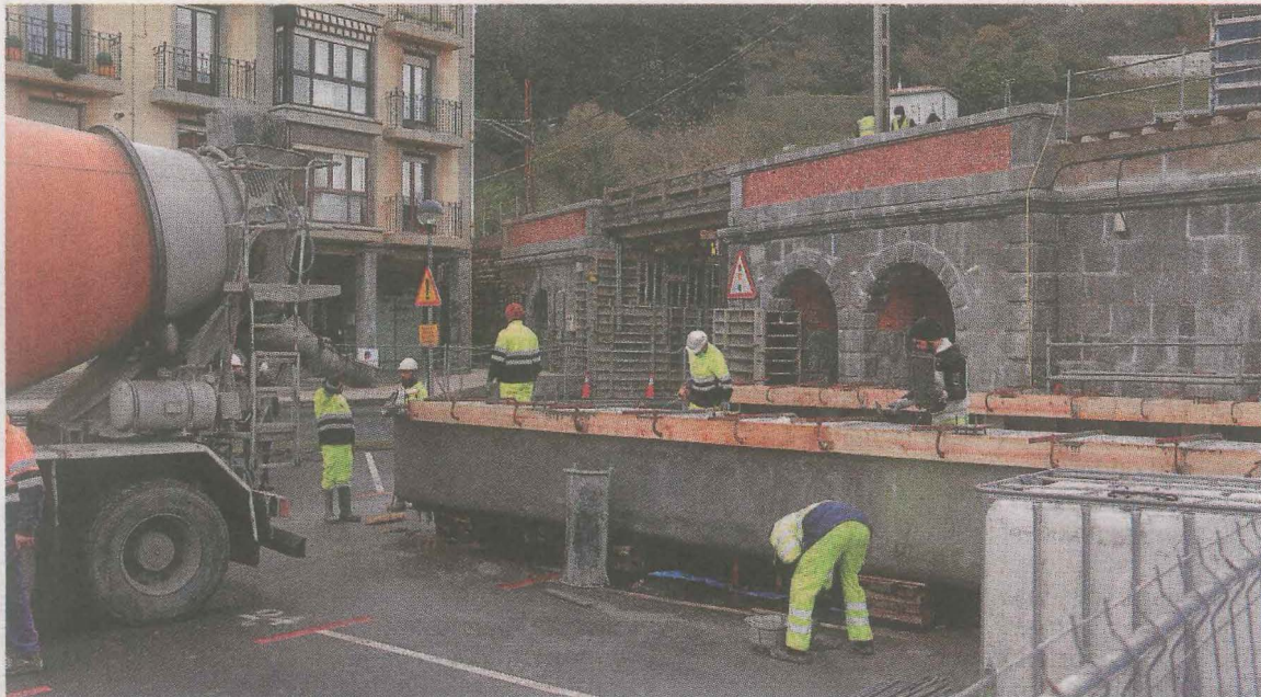
Los trabajadores preparan la estructura de acero inoxidable para el puente. SALEGI
