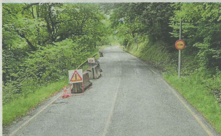
El proyecto de las obras se licitará en septiembre. Foto: DEIA
