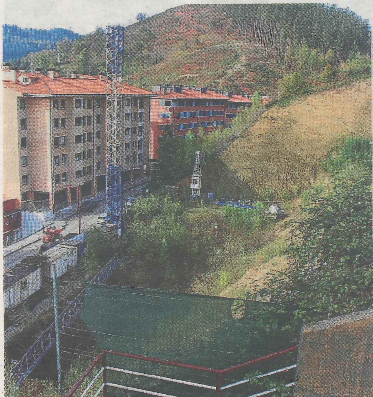
Solar en el que se construirán las viviendas. A. LASUEN
