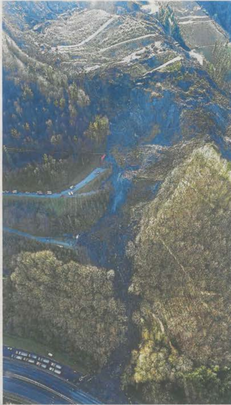
Imagen cenital del colapso del vertedero. Foto: Cedida
