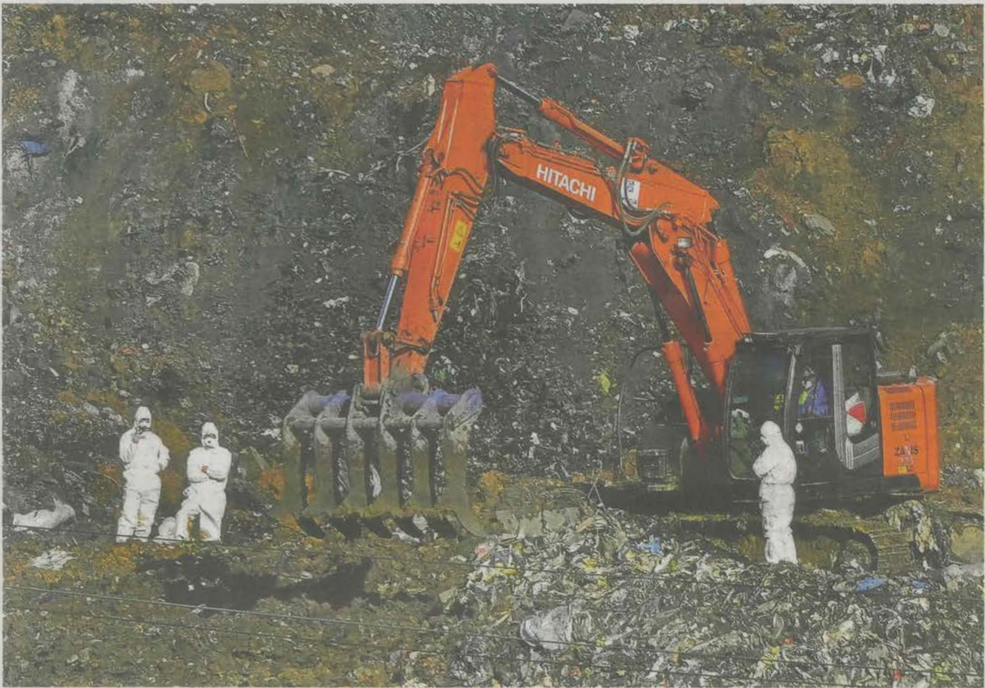
Varios operarios trabajaban ayer en el cribado de los residuos en la zona B-4 del vertedero derrumbado. IGNACIO PÉREZ
