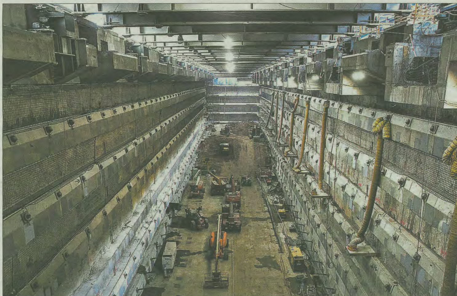
Las máquinas trabajan en el subsuelo del estadio Santiago Bernabéu, en la estructura que ocultará el césped cuando se celebren otros eventos. JAVI MARTÍNEZ
