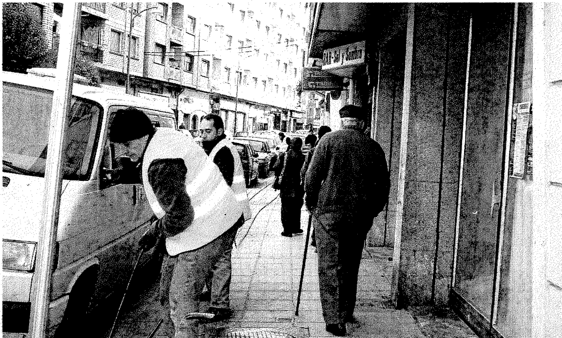
Trabajos llevados a cabo en Ermua para desplegar la red de fibra óptica. A. LASUEN
