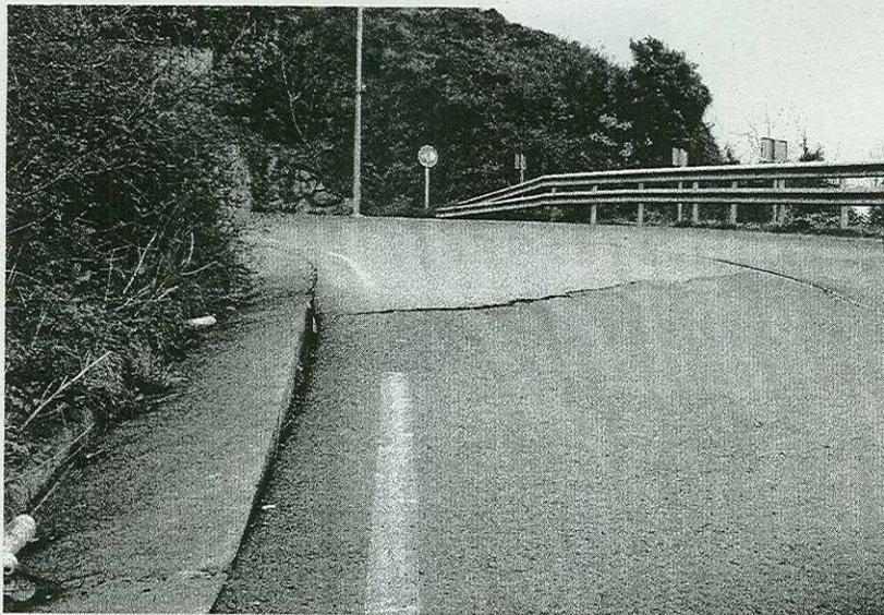
Detalle de la hondonada y sus consiguiente hendidura localizada a la salida del primero de los túneles.
