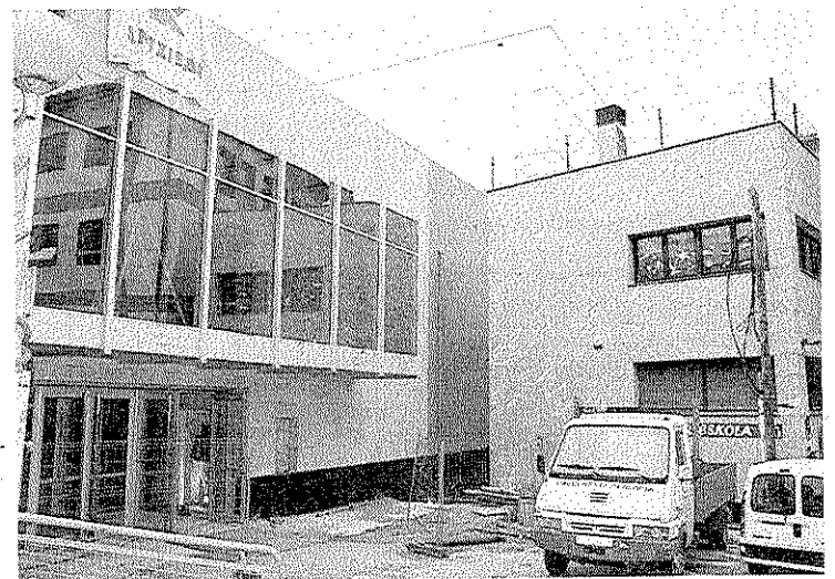
Las obras continúan en el exterior del edificio. :: A. L.
