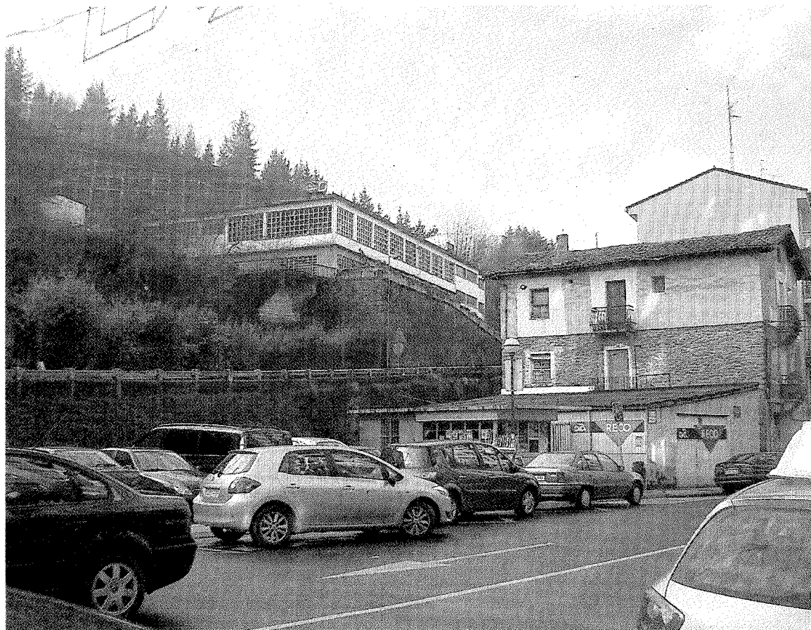
Un paso subterráneo desde este punto, bajo la N-634, dará acceso a la nueva urbanización. ■ A. L.
