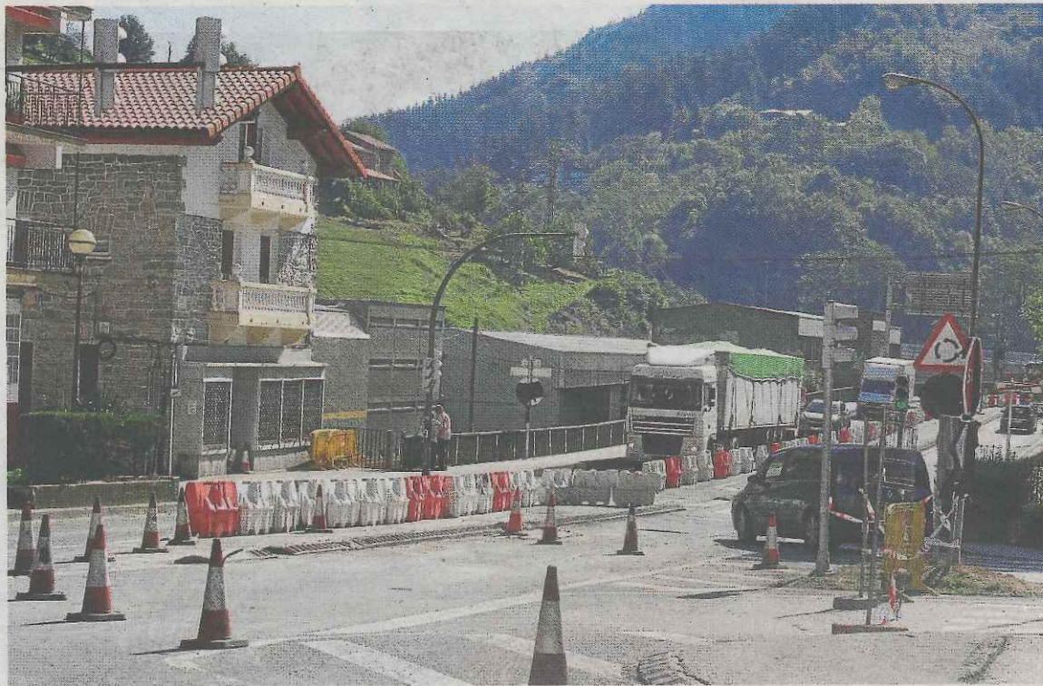
Obras que se ejecutaron en la zona donde se localizaron las balsas de agua. ■ A. LASUEN
