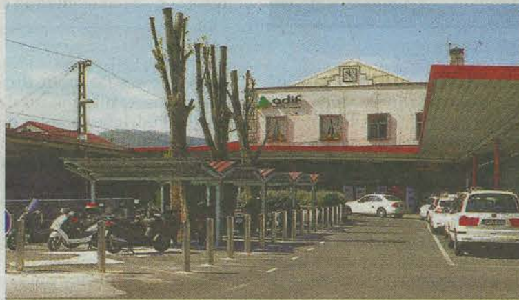
Entrada principal a la estación de Adif en Irun.
