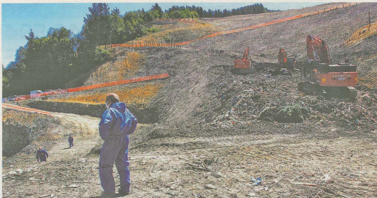
Movimiento de tierras para localizar los cuerpos de los dos trabajadores del vertedero de Zaldibar, sepultados por un derrumbamiento. MANU CECILIO
