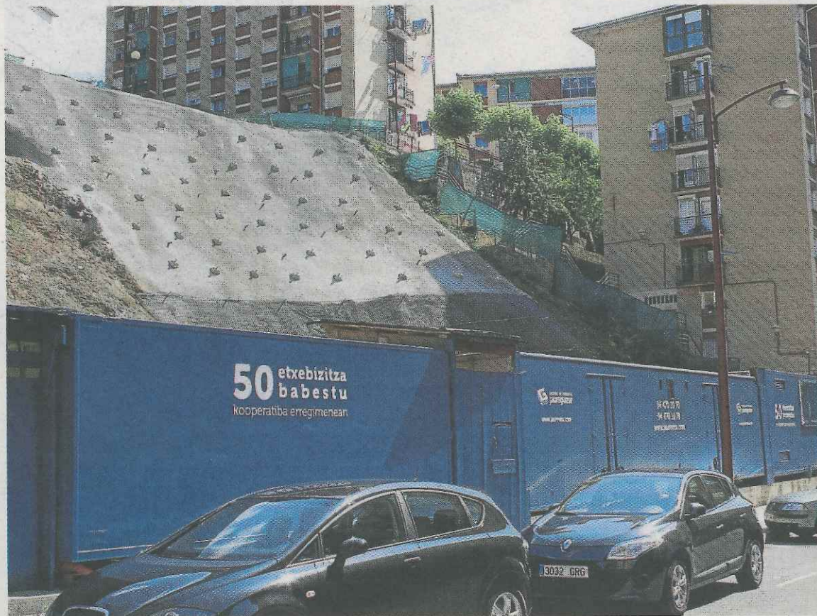
Imagen del lugar en el que se instalará el ascensor de Aldapa a Ongarai. A. LASUEN
