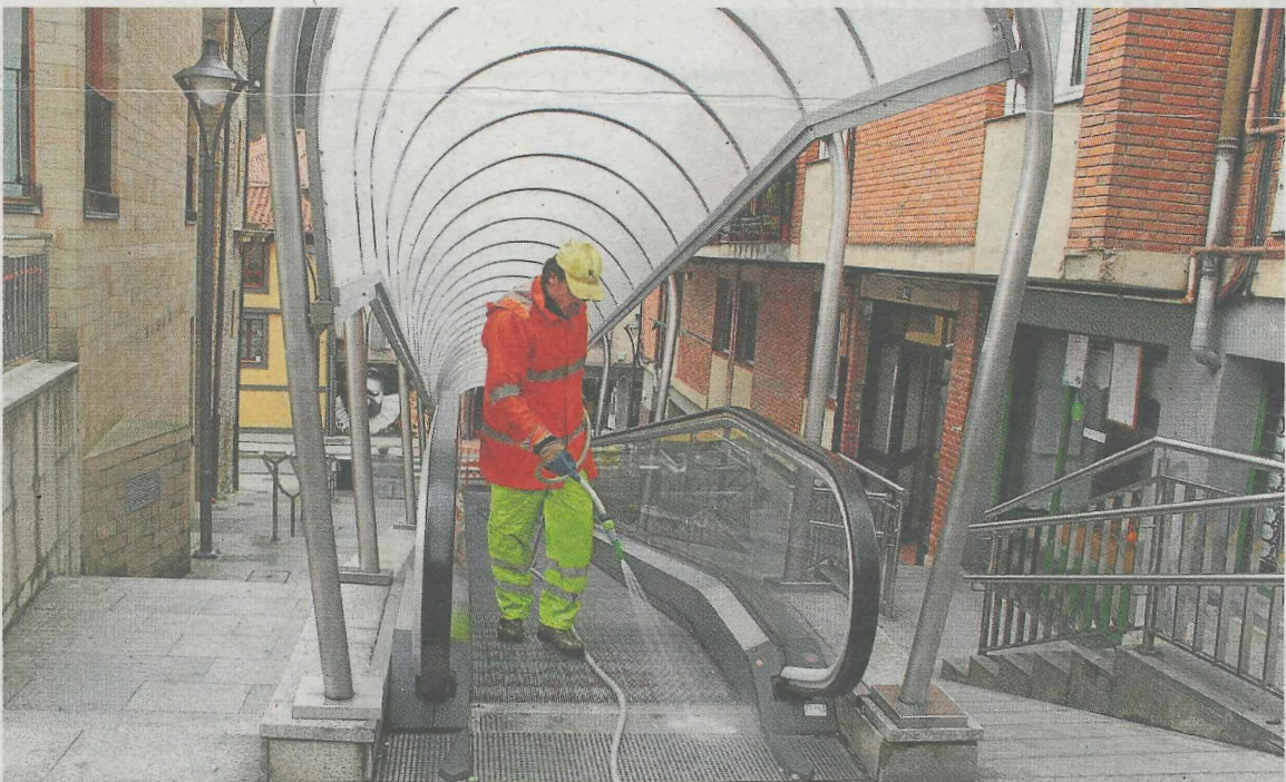
Rampa mecánica que permite el acceso a la zona ermuarra de Santa Ana. A. LASUEN
