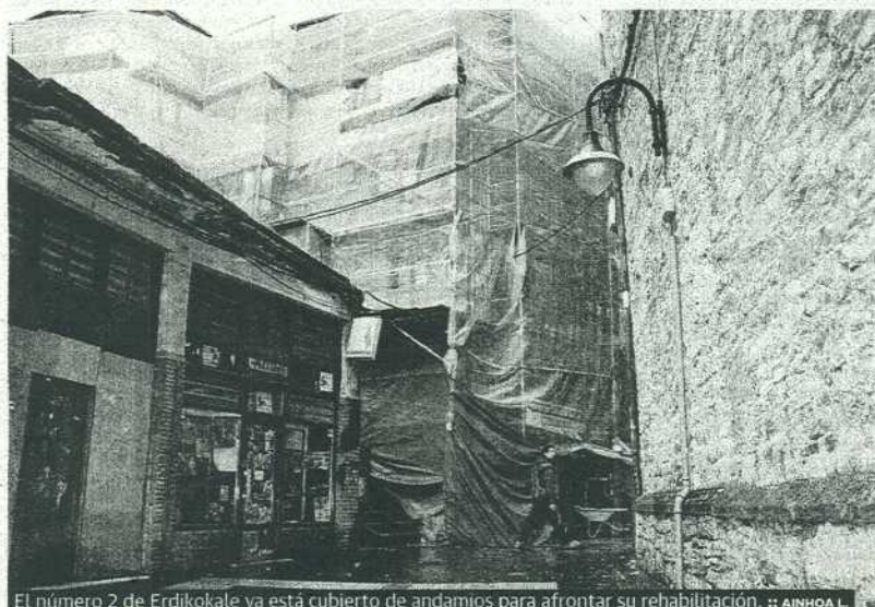
El número 2 de Erdikokale ya está cubierto de andamios para afrontar su rehabilitación. :: AINHOA L.
