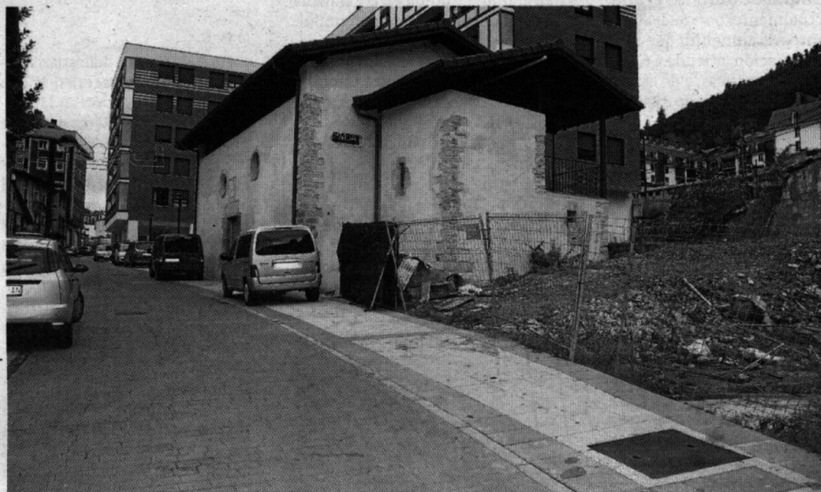
Vista de la ermita tras acometerse la primera fase de su restauración. A. LASUEN
