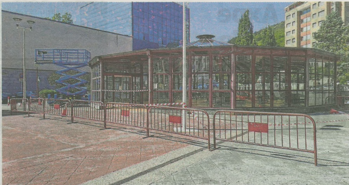
La zona permanece vallada mientras se realizan las obras de mejora en este equipamiento urbano. A. L.
