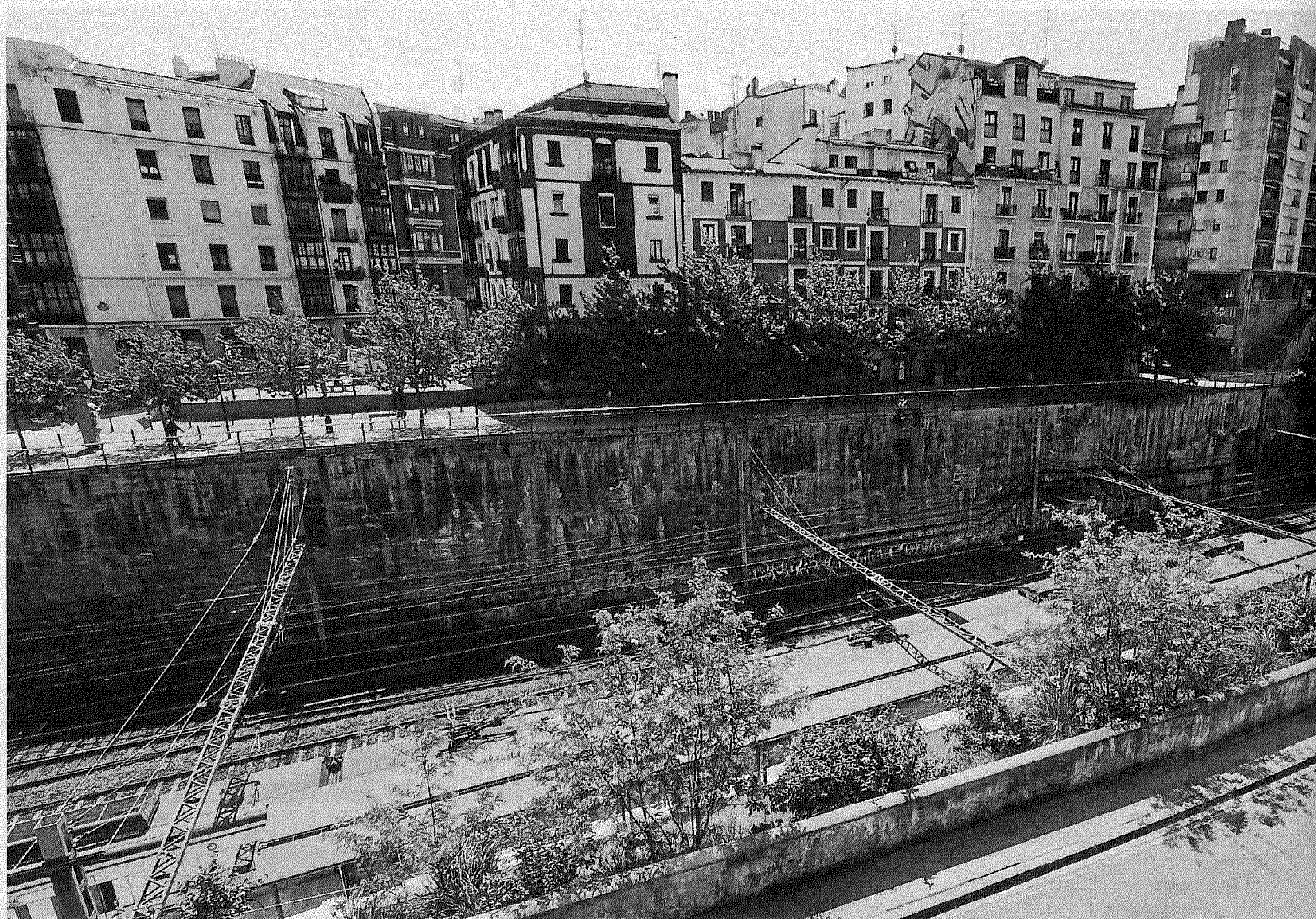
Playa de vías de la estación de Abando, en Bilbao. Foto: Oskar Martínez
