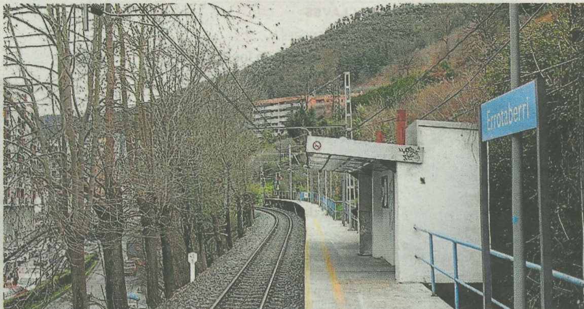
Una de las zonas afectadas por las obras de cepillado de la vía será la del apeadero de Errotabarri. A.L.
