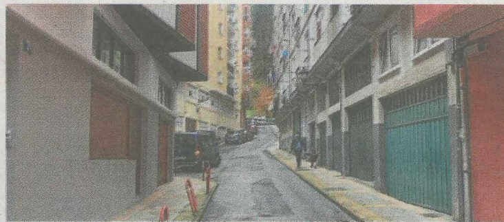
La calle Magdalena será pavimentada en los próximos días.
