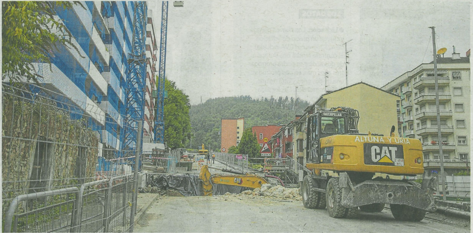
La carretera permanecerá cerrada hasta que finalicen las obras, previsiblemente en torno al 10 de septiembre. Foto: Ermuako Udala
