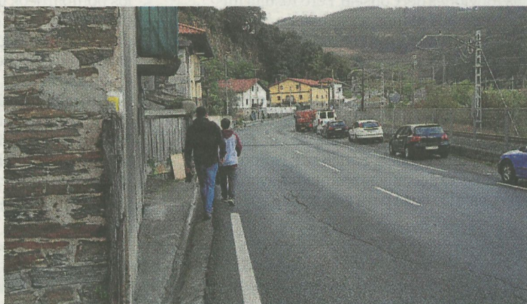
La nueva acera facilitará el paso de peatones en el barrio de Artzabal.
