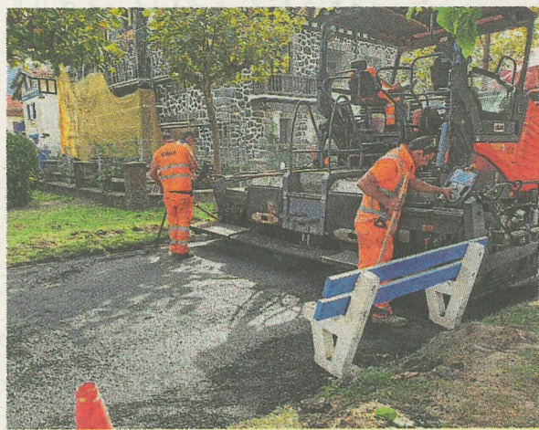
Trabajos de asfaltado en arrantzale kalea. FOTOS A.SALEGI
