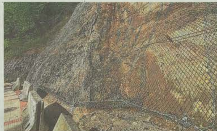
Se han instalado mallas metálicas para evitar deslizamientos. AYTO.
